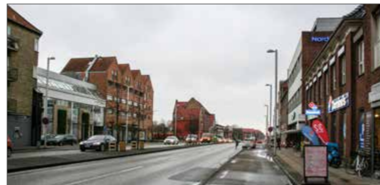
1. Hovedvejen set mod vest. Der er sparsom plads til skiltning og cykelparkering langs fortorvet på nordsiden af denne strækning.
