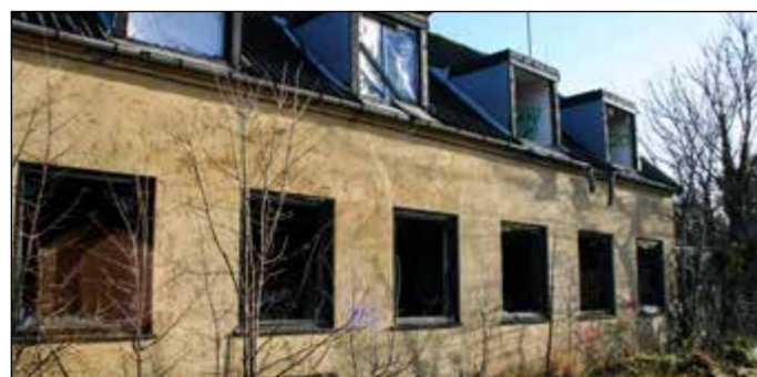
1. Bygningen øst for Ringvejen står forladt og ramponeret tilbage.
