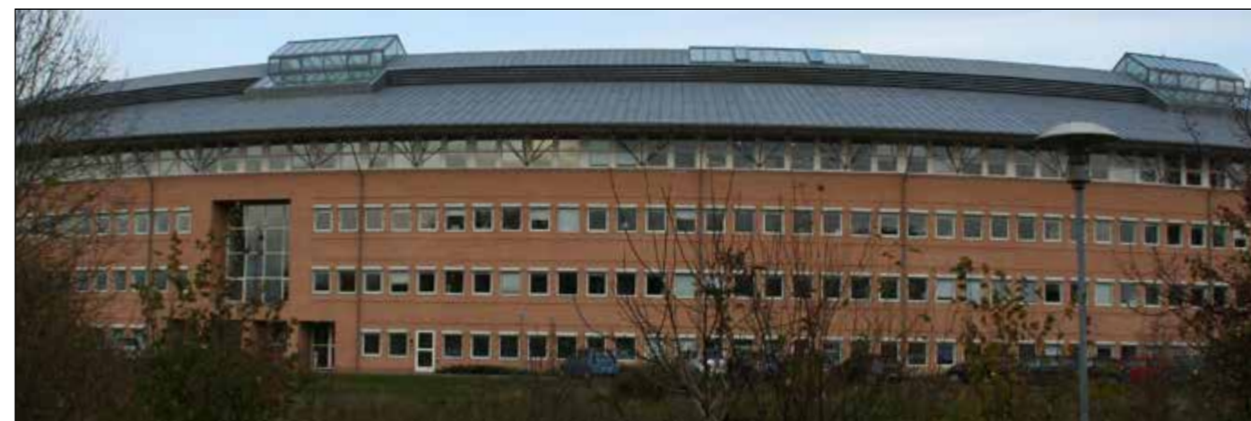
4. Fødevarestyrelsen med parkering på terræn og parkeringskælder.
