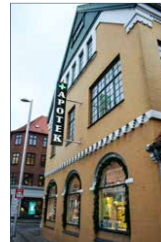
3. Apoteket fra 1908 er en af de ældste bygninger i Glostrup.
