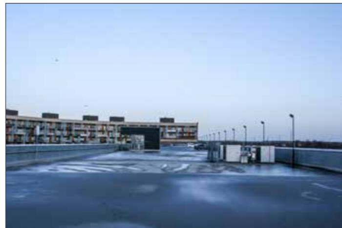
Pendlerparkeringspladserne på taget af 2G Shopping står ofte ubenyttede hen, og de kunne anvendes mere fordelagtigt med større aktivitet til følge.
