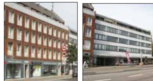
2. Større sammenhængende bygninger i nord.
