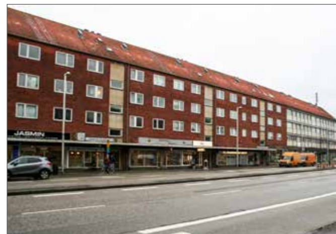
4. Større sammenhængende byggeri i syd.
