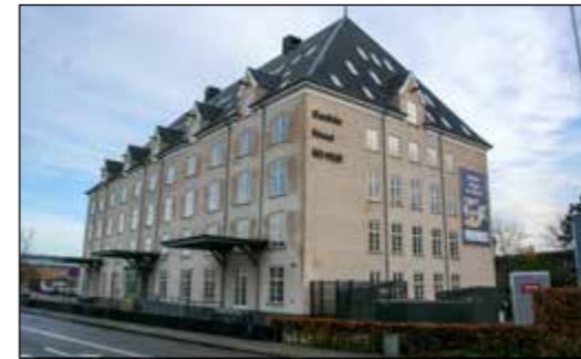
1. Hartmanns pakhus, 1919, er opført som frølager og anvendes i dag til kontorhotel.
