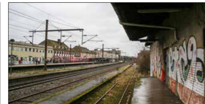
7. Tidligere lagerbygning med fungerende jernbaneteknik i kælderen.
