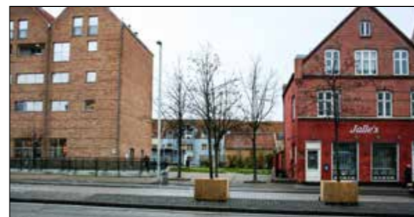
2. T.v. ses nedgang til tunnel til nordsiden af Hovedvejen. I midten ses passage mellem to bygninger til bykernen, og i forgrunden ses en midterhelle med nyplantede træer.
