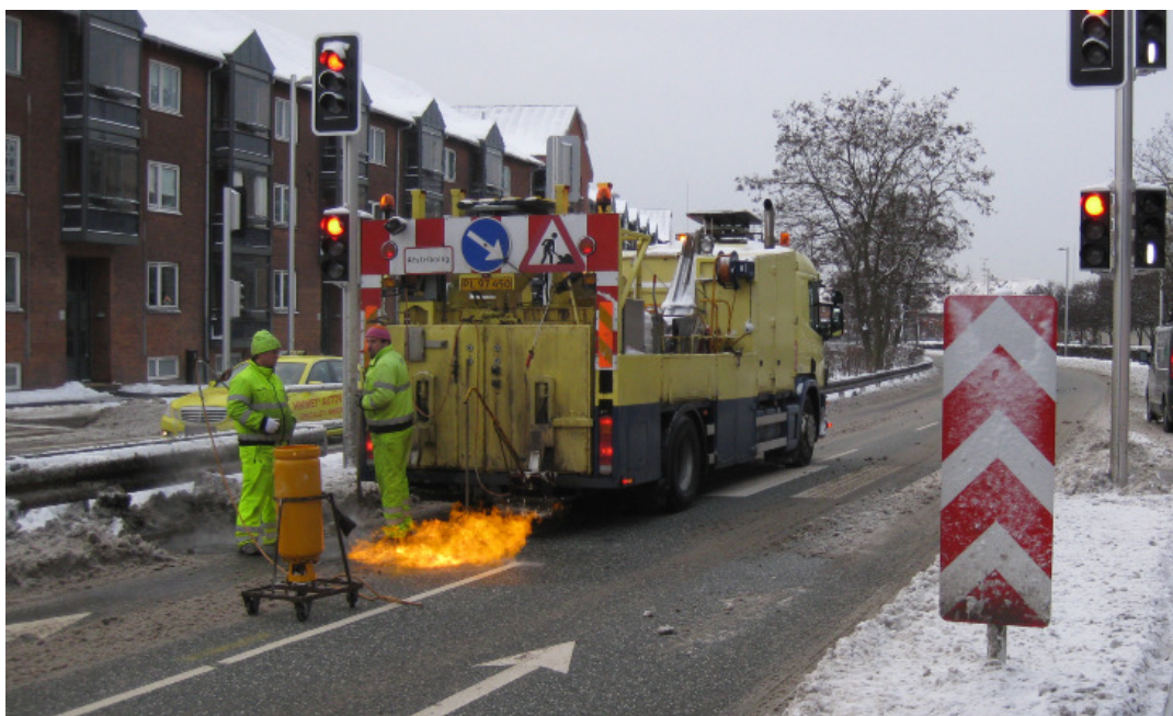
Foto: Der blev også arbejdet på ombygningen af Ringvejen på kolde dage. Her arbejdes på fodgængerovergangen på Nordre Ringvej nord for Hovedvejen.
