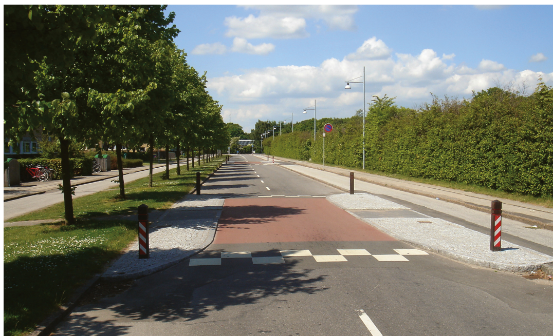
Foto: Stadionvej er kategoriseret som lokalvej på dette sted, hvor den er indrettet med hastighedsdæmpende foranstaltninger.
