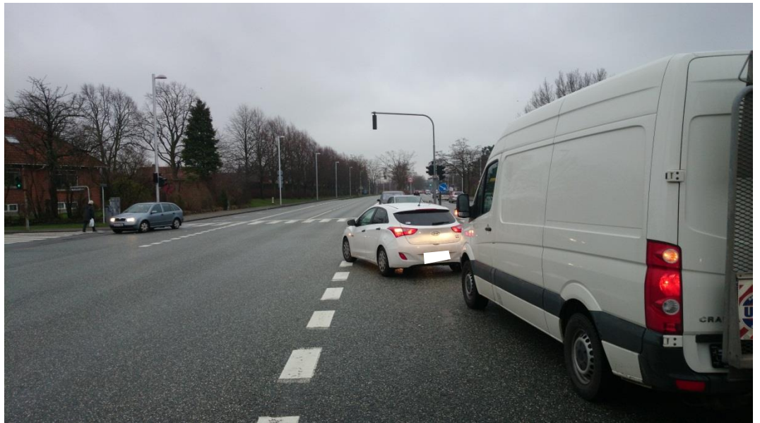
Figur 41. Krydset Nordre Ringvej/Gammel Landevej/Mellemtoftevej set mod syd. Der er dårlig oversigt for venstresvingende trafikanter.
