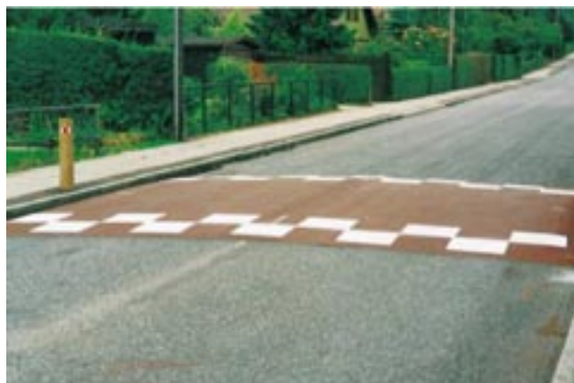
Bump i hastighedszone i Mørkhøjområdet, Gladsaxe Kommune.
