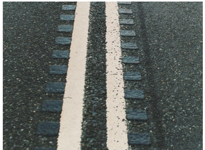
Midterafstribring fremhævet med fræsning i asfalten. (Esrumvej, Frederiksborg Amt)
