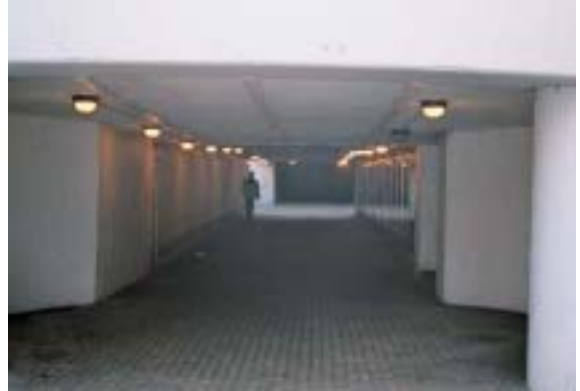
Eksisterende forhold Med et ovenlys vil tunnelen få en spændende effekt og føles mere tryk.
