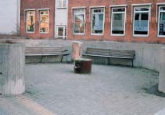
Eksisterende forhold Betonmurene ned til tunnelen kan erstattes af mere transparente skærme.
