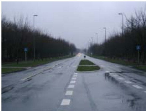
Fraligsvej set fra vest mod øst.
