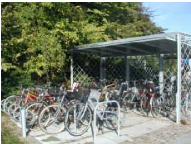
De nye cykelskure ved Gl. Landevej, som er meget brugte.
