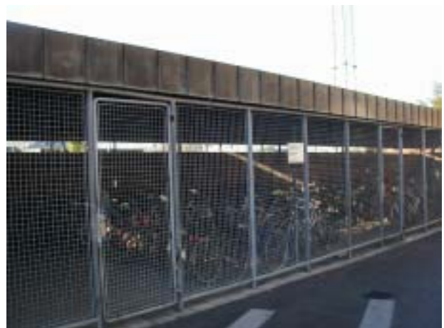
De aflåste cykelparkeringspladser ved Glostrup Station.
