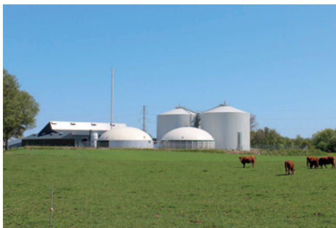
Solrød Biogas – sommer 2016.
