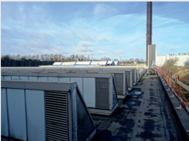
Fra energirenovering af Hvidovre Hospital
