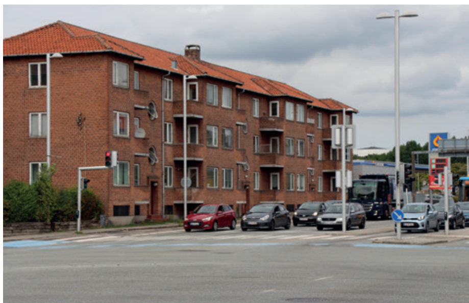
En del bygninger omkring Ringvejskrydset bliver revet ned for at gøre plads til letbanen.
