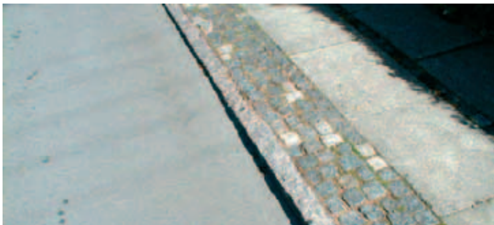
Belægning med chaussésten
