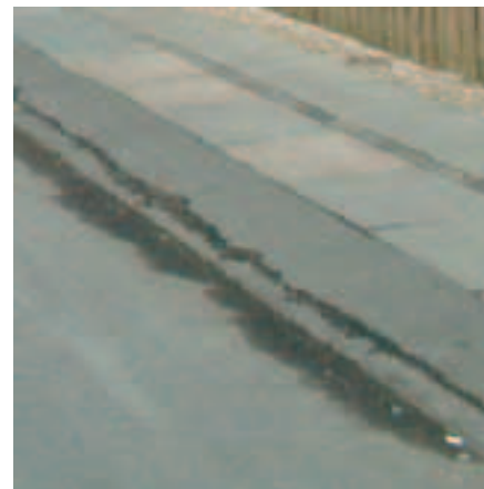
Belægning med asfalt
