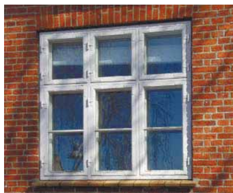
Dannebrogsvindue med lod- og tværpost samt sprosser
