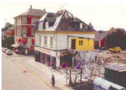
Skrædderen på Jernbanevej nedrives, 1990
