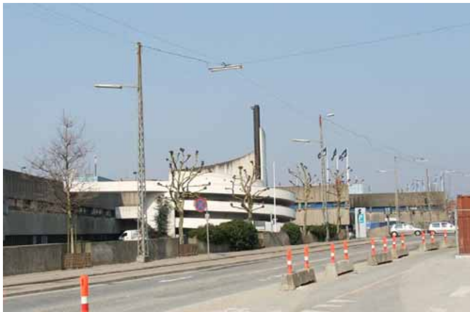
Parkeringsneglen på Banegårdsvej
