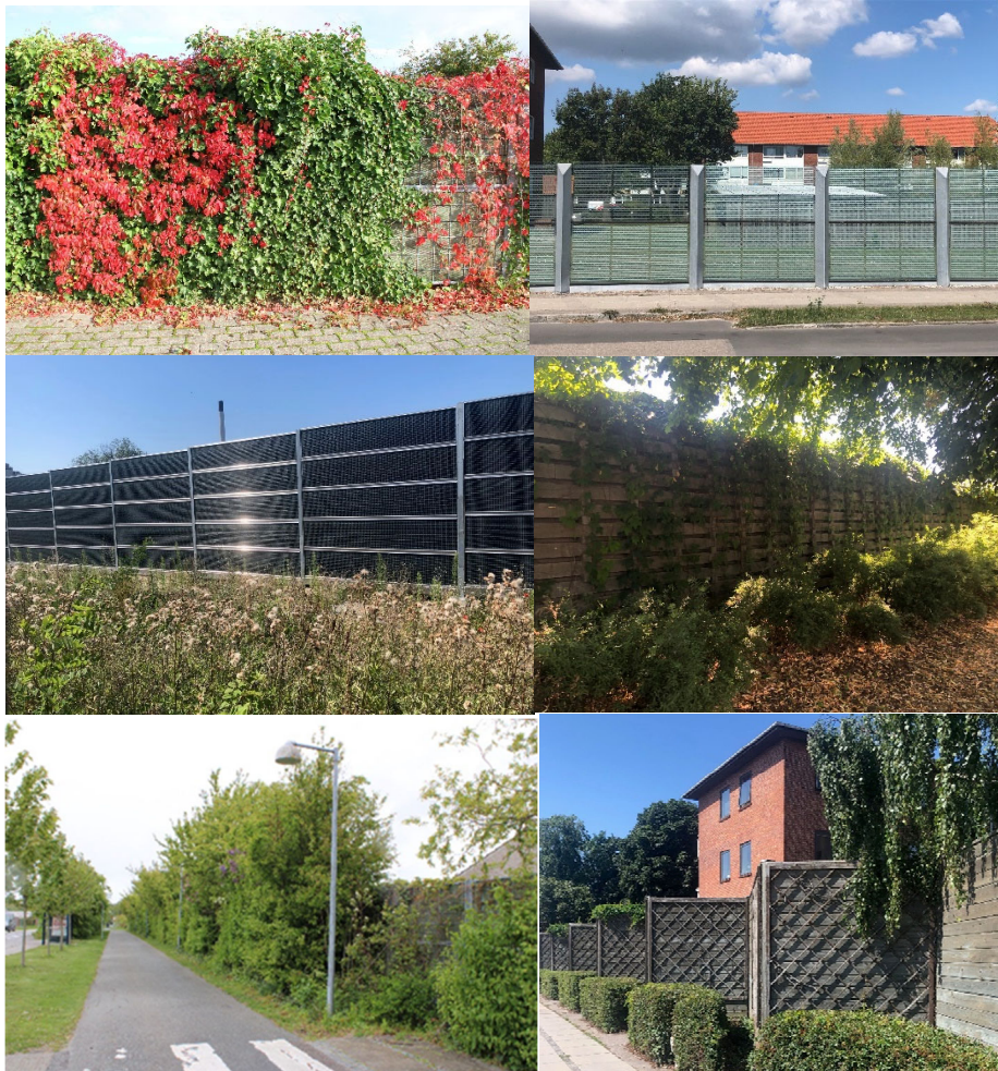
Forskellige former for støjhegn og begrønnet støjhegn i Glostrup Kommune
